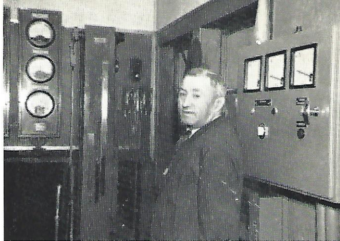
Brugwachter van Passel bij het schakelbord.
